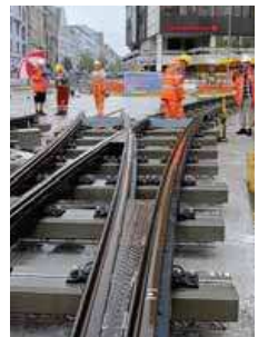
Elf Transporter lieferten gestern die Schienen an, zwölf weitere kommen noch. Heute beginnen Arbeiter, die bis zu 25 Meter langen Gleise zu positionieren. Laut Projektleiterin Stefanie Rohde und Gleisbauerleiter Klaus Rhee läuft alles nach Plan. Künftig werden viel mehr Gleise über den Kö und die Kaiserhofkreuzung führen. Fotos: Anne Wall
